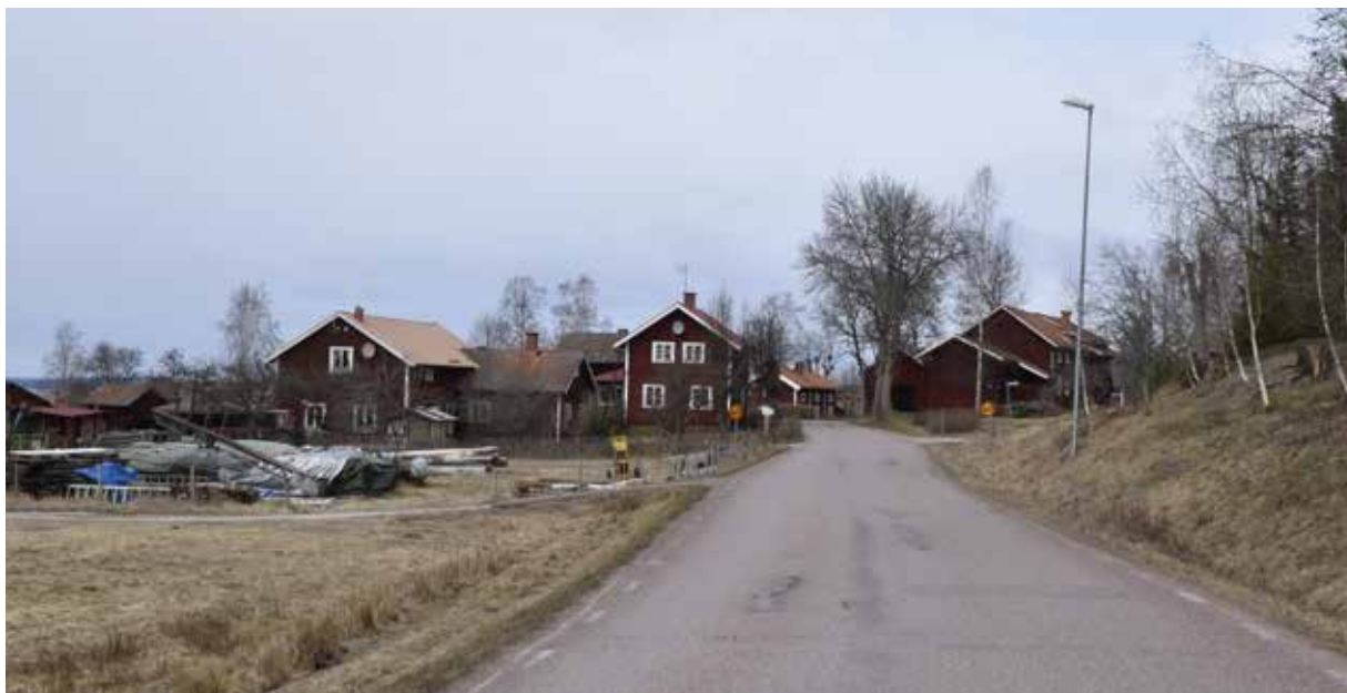
Vid anfarten till Sunnanäng möts besökaren av två fyrkantbyggda gårdar med mycket gamla anor till vänster och en nyare kringbyggd gård till höger. Den fyrkantbyggda gården till höger i bild är Lindgården. Sunnanäng 11:1.
